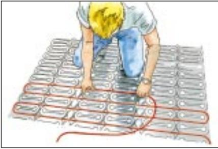
das **Deviflex™** Heizkabel DTIE 10 in die dafür vorgesehenen Kanäle so eingedrückt, dass es nicht gequetscht – oder
