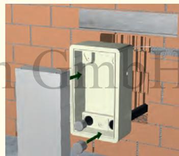
Befestigen Sie den Wand-einbaukasten in der Wand. Stecken Sie anschließend die Lüftungsrohre, die Rohrverschlüsse innen und den Putzdeckel in den Wandeinbaukasten.
